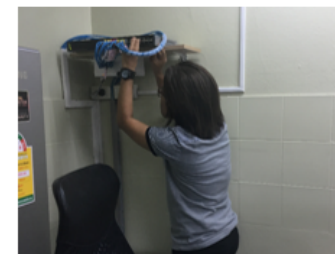
ตรวจสอบ Switch Hub ๒๔ Ports เพื่อดำเนินการสลับสาย LAN และ ตั้งค่า DNS ใหม่
